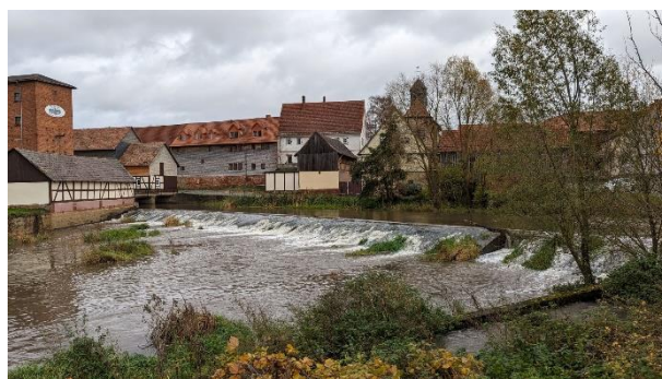
Wehr an der Rommershäuser Mühle
